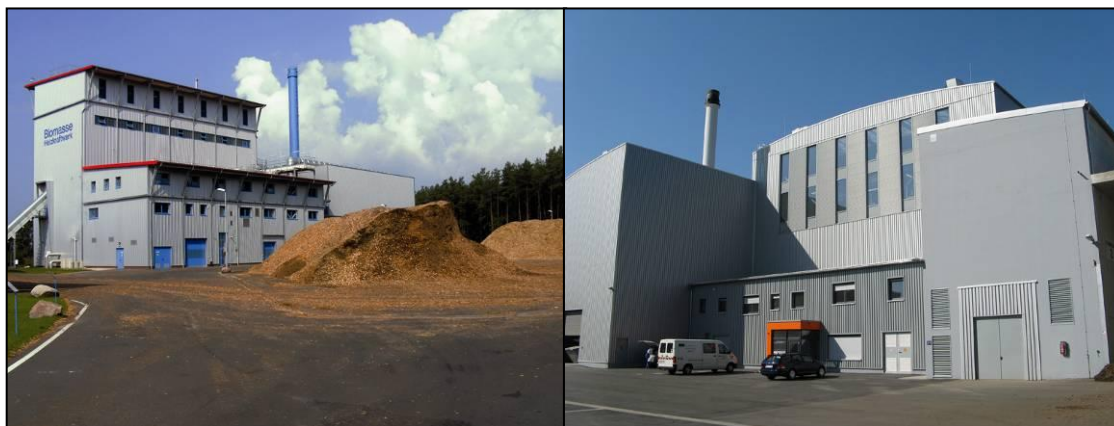
Ábra 35: 7,5 MW villamos teljesítményű elvételes kondenzációs turbinával (bal oldal) és 2,6 MW villamos teljesítményű fűtőturbinával (job oldal) szerelt víz-gőz ciklusú biomassza erőmű
